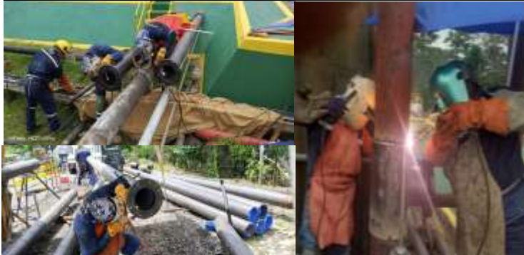
CONSTRUCCIÓN, MONTAJE DE LÍNEAS PARA CALENTADOR CAMPO CPF TIGÜINO
