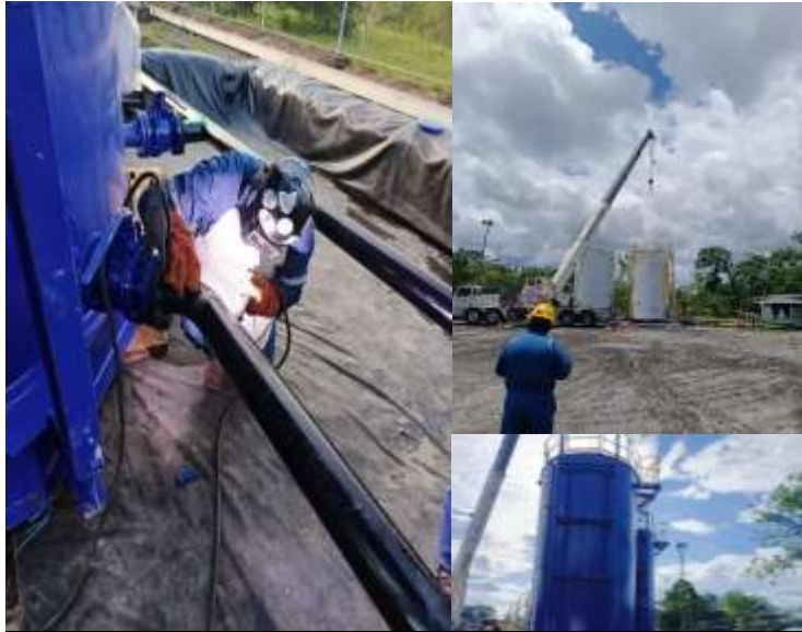
MONTAJE E INTERCONEXIÓN DE LÍNEAS EN EL PAD AUCA AUCA 37
