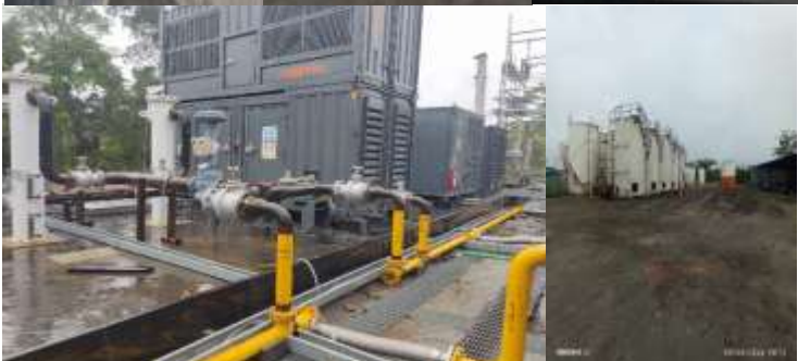
CONSTRUCCIÓN Y MONTAJE DE LINIA DE GAS PARA GENERACIÓN AGGREKO PAD AUCA 123
