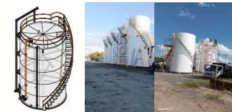
CONSTRUCCIÓN Y ARMADO DE ESCALERAS, PASAMANOS PARA TANQUES DE SLB
