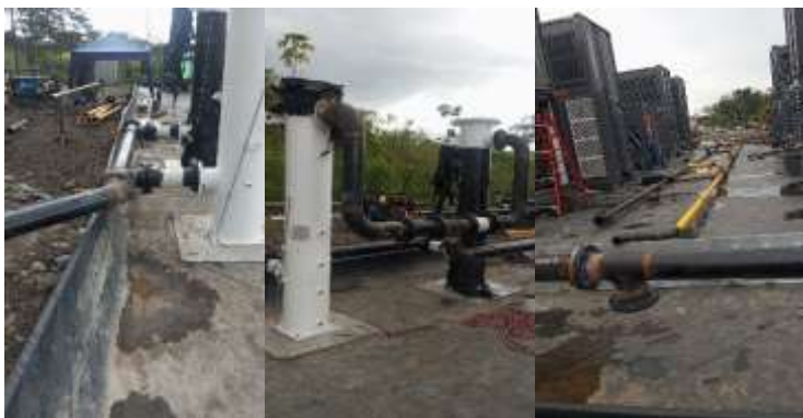
CONSTRUCCIÓN, MONTAJE DE LÍNEAS PARA CALENTADOR CAMPO CPF TIGÜINO
